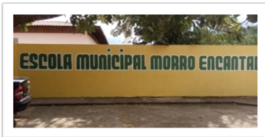
Figura 3 - Escola Municipal Morro Encantado – Fachada.
